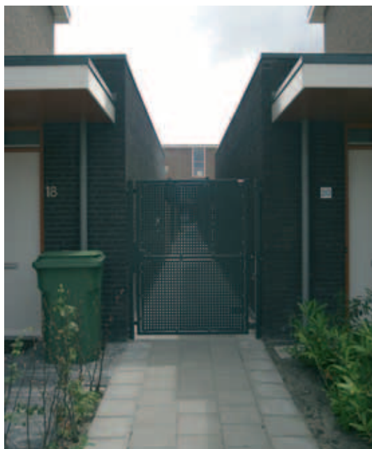
Achterpad afgesloten met toegangshek
