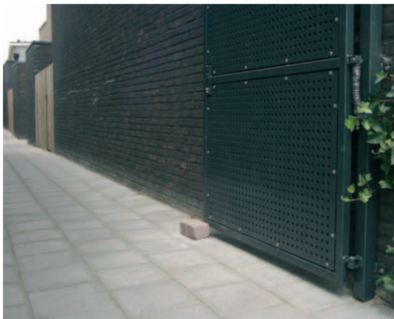
Fout: toegangshek heeft op deze manier geen nut
