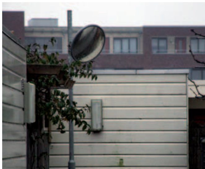
Spiegels kunnen het overzicht verbeteren. Zorg ervoor dat spiegels geen zicht bieden op de achtertuinten in verband met de privacy van bewoners.
