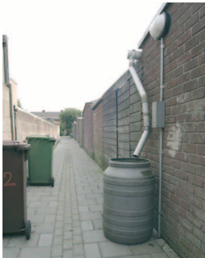
Fout: obstakels moeten worden verwijderd. De onderlinge afstand tussen de lichtpunten bedraagt maximaal zes keer de lichtpunthoogte.
